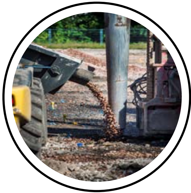
Vibro Stone Columns
